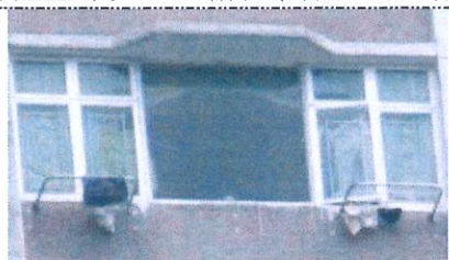
× 拆除冷氣機窗台
