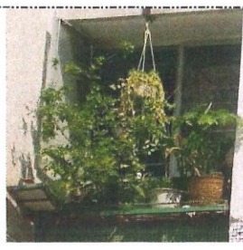
× 於花槽放置重物
